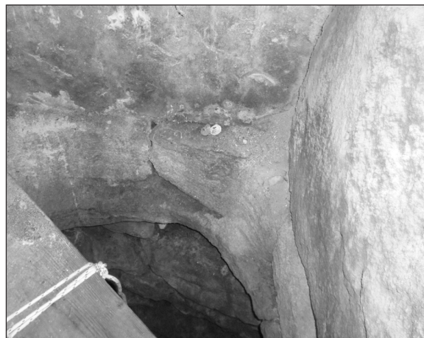
Fig. 11 - Interno del pozzo del Porticciolo di Castiglioncello. Fig. 11 - Well inside of Castiglioncello harbour.
